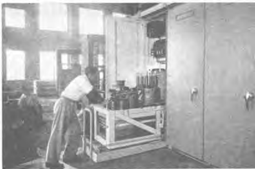
23 図 WB型用台車および屋外移動車 Fig. 23. Type WB transfer track and dooly.
