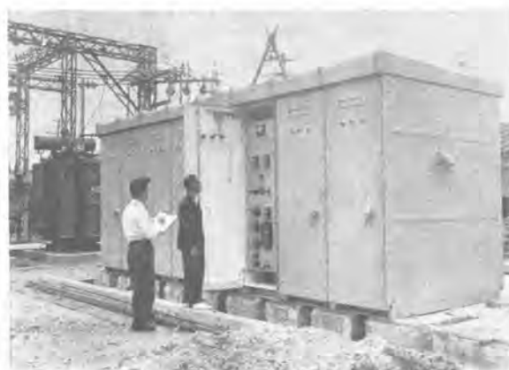
17 図 屋外用メタルクラッド配電盤(中部電力振甫 s/s 用)
