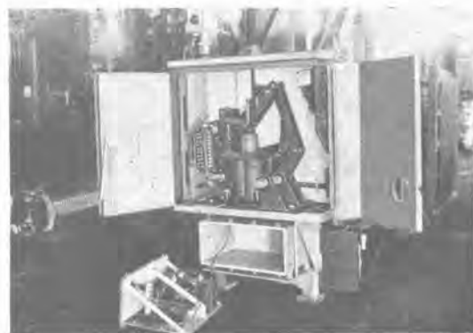
(b) キャパシタトリップ装置を引出した所 (b) Capacitor trip apparatus taken out.
