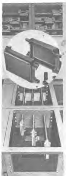
12 図 母線室 Fig. 12. Bus chamber.
