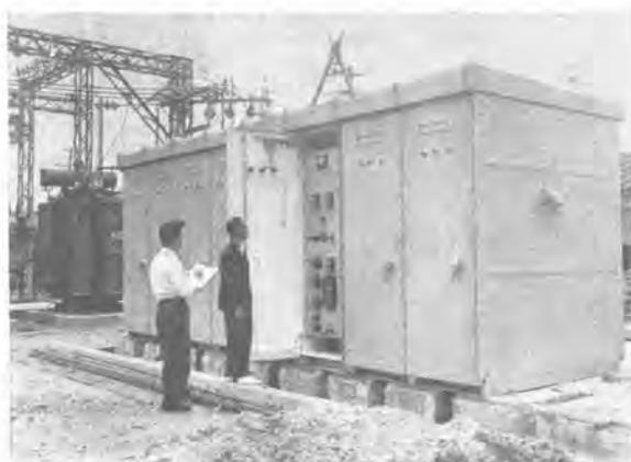
17 図 屋外用メタルクラッド配電盤(中部電力振甫 s/s 用) Fig. 17. Out door metal clad switchgear.
