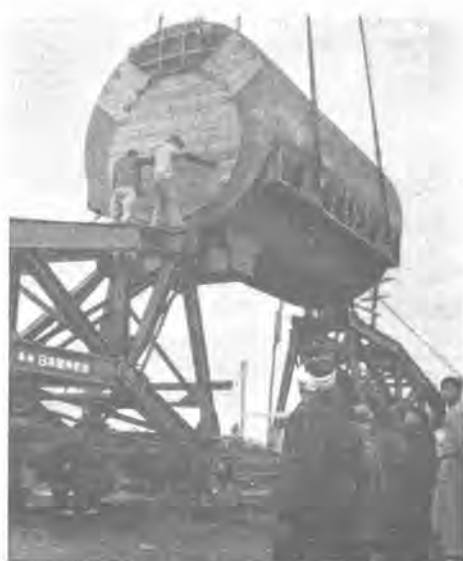
8 図 固定子挿入状況 Fig. 8. Insertion of stator.
