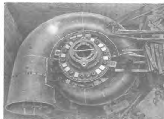
10 図 スパイラルケーシング現場溶接 Fig. 10. Welding of spiral casing on the spot.
