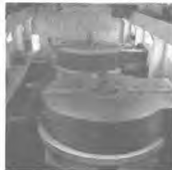
2 図 11000 kVA 傘型発電機 Fig. 2. 11000 kVA umbrella type water generator.
