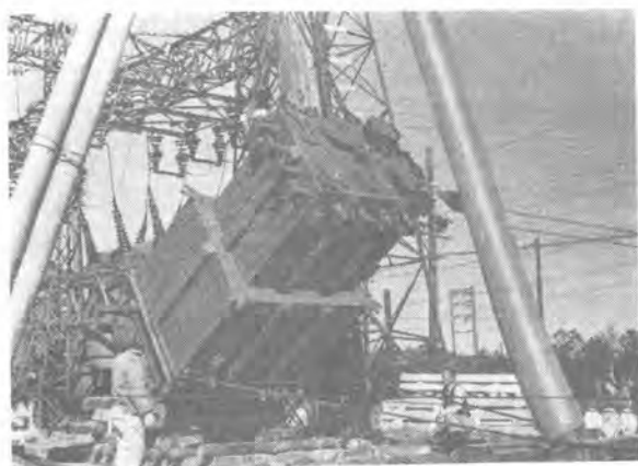
8 図 単相 15,000kVA フォームフィット 変圧器の現場起し作業
