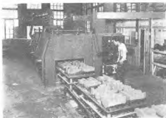
鋳型乾燥に役立つ DH-3 型ラジオヒータ High frequency heating equipment.
