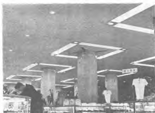
埋込 40 W 3 灯器具と回転式 ダウンライト器具 (大阪十合デパート) Fluorescent luminaires for department store.
