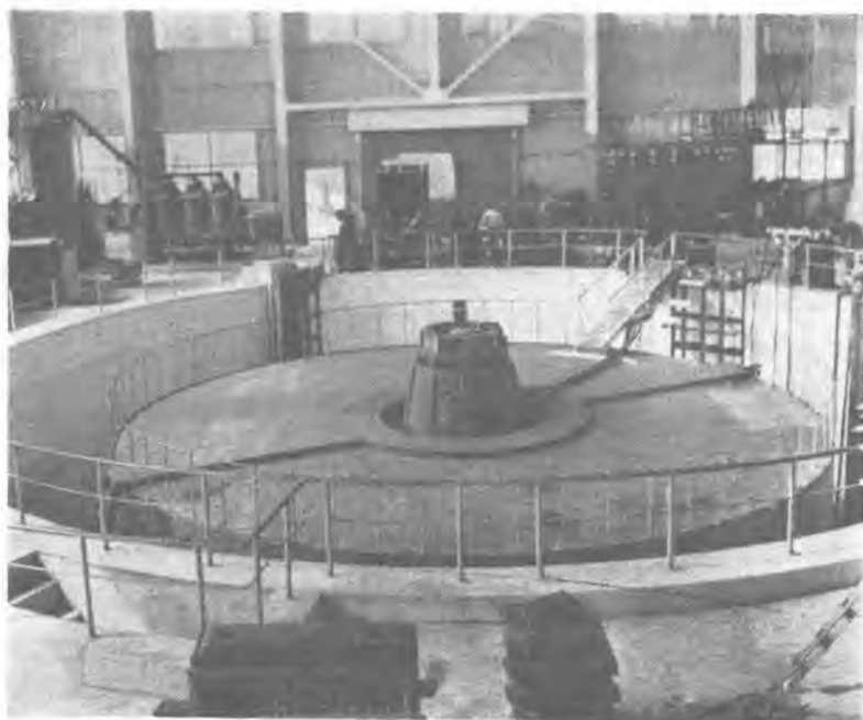
ピット内における 過速度試験を無事好成績に収めた 柳津発電所納 30,000 kVA 傘型水車発電機 30,000 kVA umbrella type water wheel generator in the testing pit.
