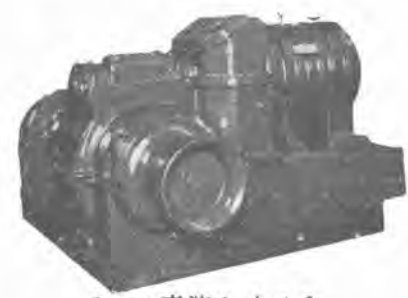
3 トン交流ウインチ 3-Ton AC electric cargo winch for deck use.
