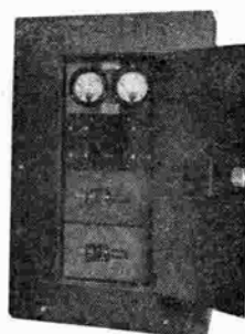
6 図 東京ビル納入 NF 型ノーヒューズ 動力分電盤(30HP. 冷房装置用) Fig. 6. Type NF no-fuse distribution board for power supply(30HP air conditioning) in the Tokyo Building.
