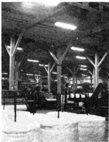
10 図 紡績工場用照明 (日東紡績静岡工場)
