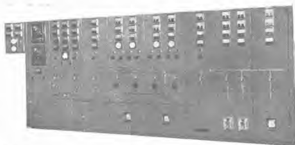
水車発電機用全配電盤
