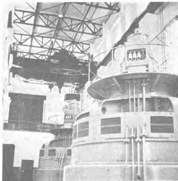
旭化成水ヶ崎発電所納 10,000kVA フランシス水車発電機
