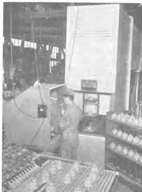
赤外線乾燥装置（扇風機塗装）
