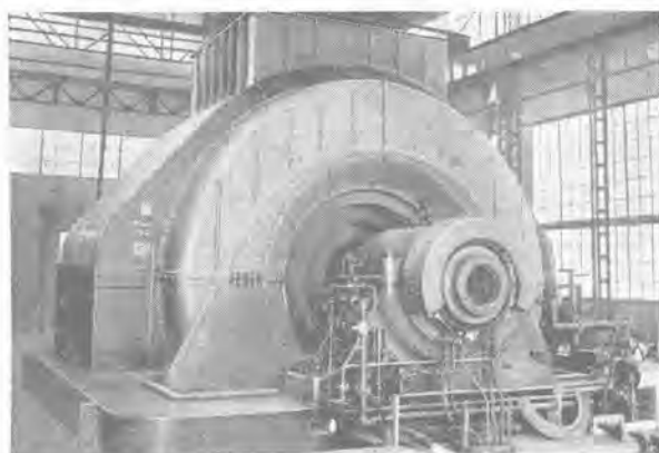
大電力遮断試験所における 50,000kVA短絡試験用発電機の勇姿
