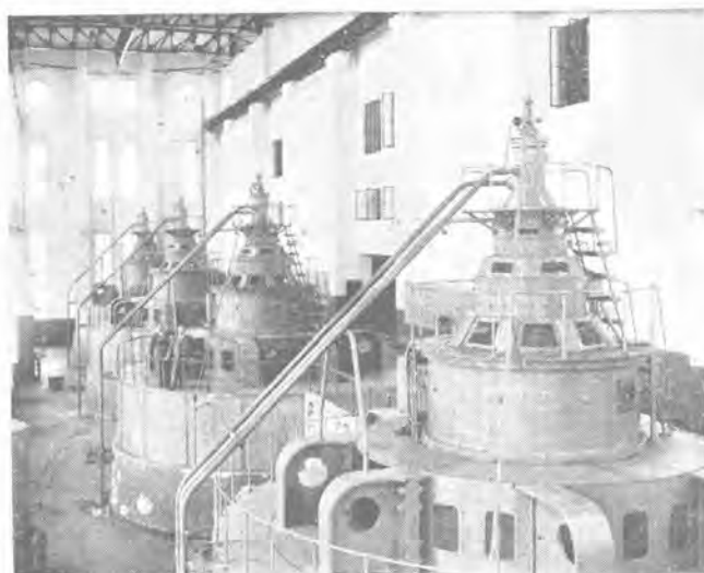
日新郷発電所納 14,000kVA カプラン水車発電機
