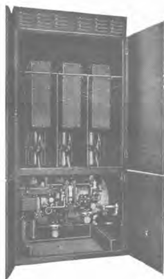
鉄箱に収められた 20-C-150型 圧縮空気吹付遮断器
