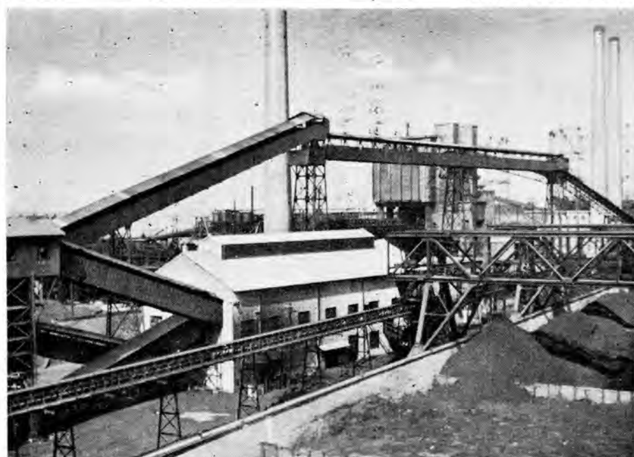
2 図 貯炭場および粉碎混合室 (大坂ガス西島工場)
