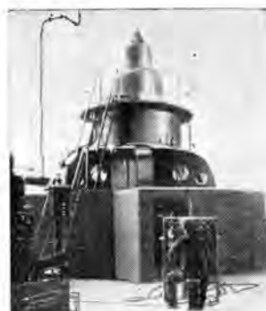
大井川発電所にて発電機測定中
