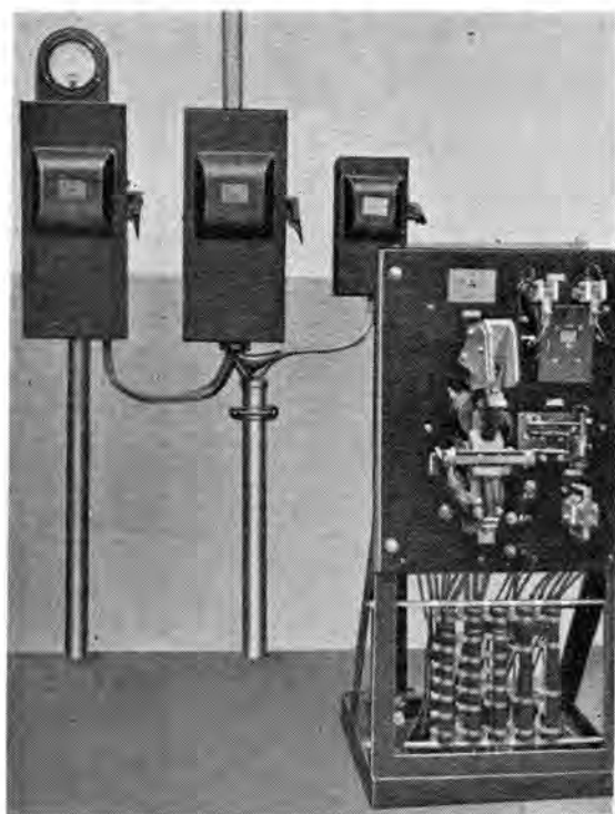
14 図 回り舞台制御盤
