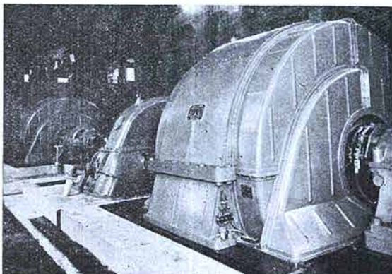
1 図 日本窒素内谷川第一発電所納入 1,000kVA 50/60 \sim 500/600rpm横軸ベルトン水車発電機
