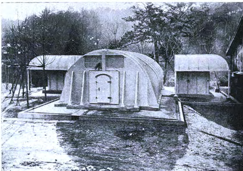
2 図 日 発 神 戸 変 電 所 納 入 屋 外 用 同 期 調 相 機 15,000kVA 11,000V 60~900rpm 8極 自己起動
