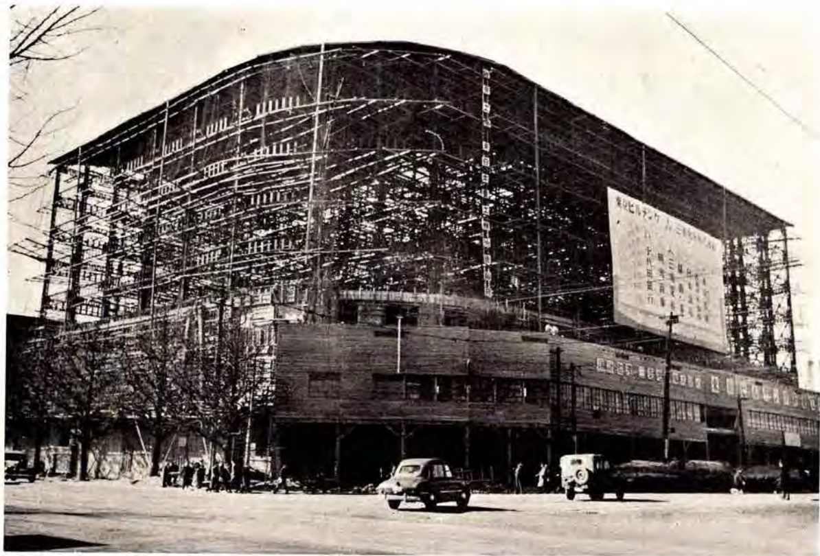
竣工間近い東京ビルディング (昭26-3-22撮)
