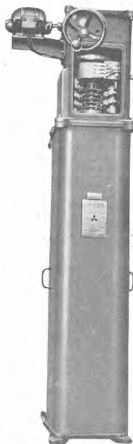
18 図 電動操作式主幹制御器
