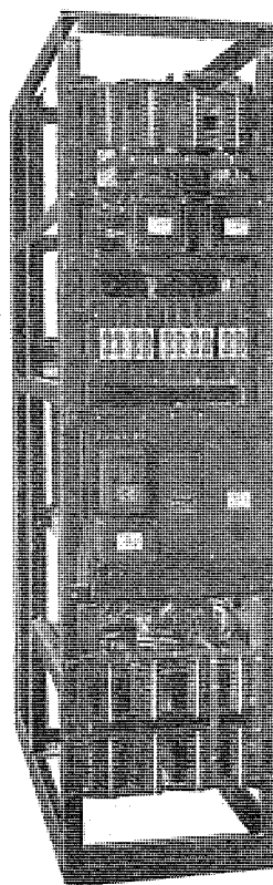
化學用水銀整流器真空制御盤
