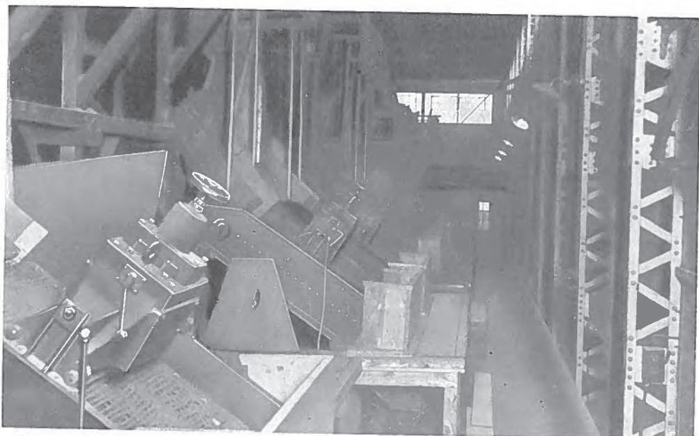
第5圖 ハンマー・スクリーンの使用状態
