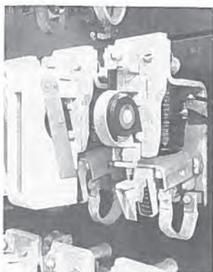
DH-300 型 電磁接觸器
