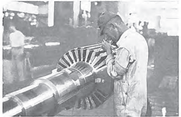
第 6 圖 検孔鏡による検査
