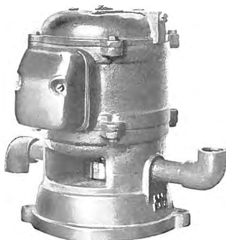
第 2 図 NP 型三菱電動油 ポンプ 1/4 馬力全閉型
