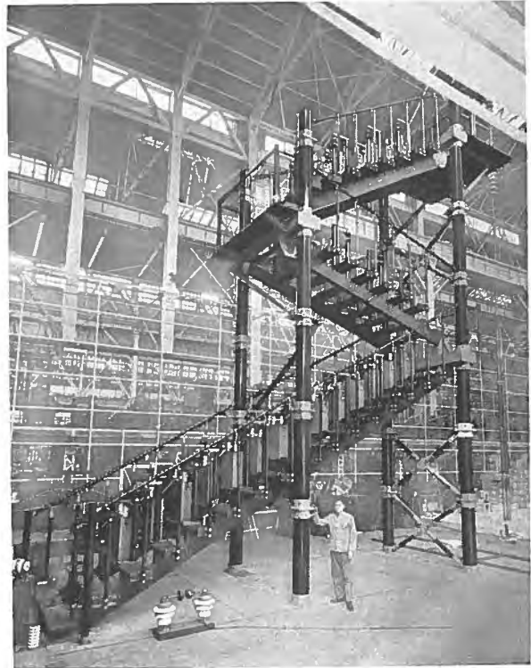
第16圖 3,600 kV 衝撃電壓發生裝置
