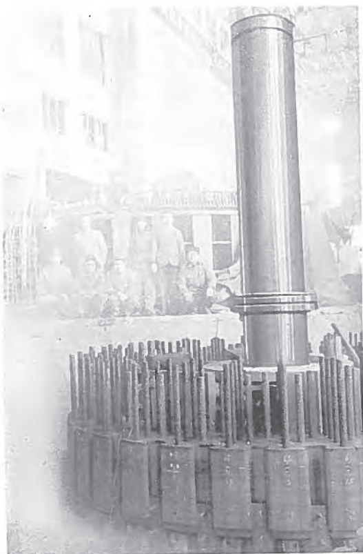
第10圖 組立中のスパイダーリム
