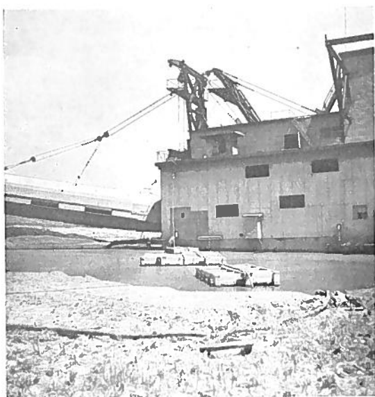
第5図 ケーブル導入状況
