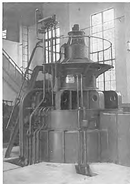
安積發電所 3,500 kVA 600 r.p.m. 水車發電機 3,500 kVA 600 r.p.m. Vertical Water Wheel Generator for Azumi Power Station
