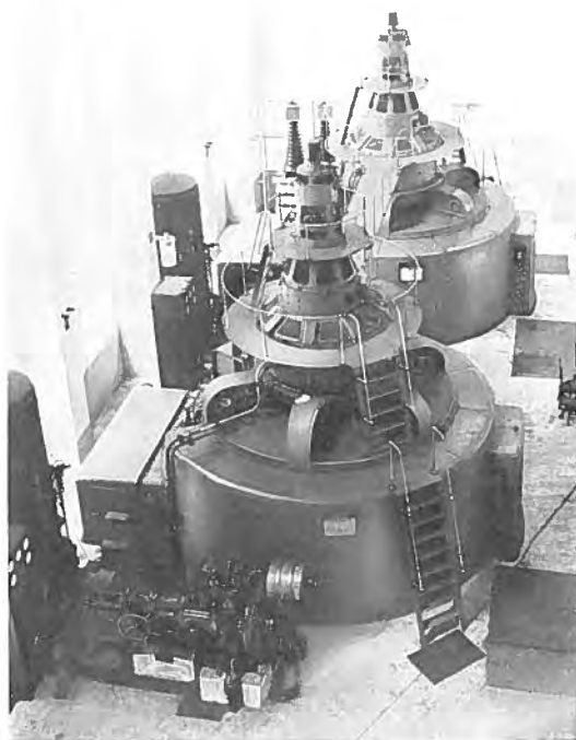
日本電力株式会社 瀬戸發電所 12,500 kVA 514 r.p.m. 水車發電機 12,500 kVA 514 r.p.m. Vertical Water Wheel Generator for Seto Power Station, Nihon Denryoku K.K.
