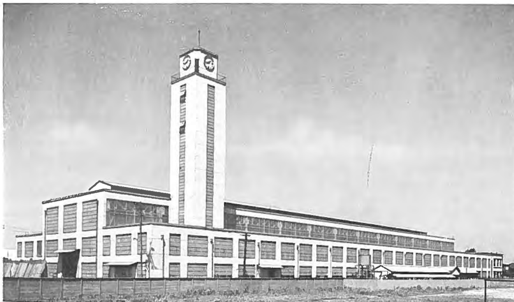
エ レ ベ ー タ 試 驗 塔 Testing Tower for Elevator
