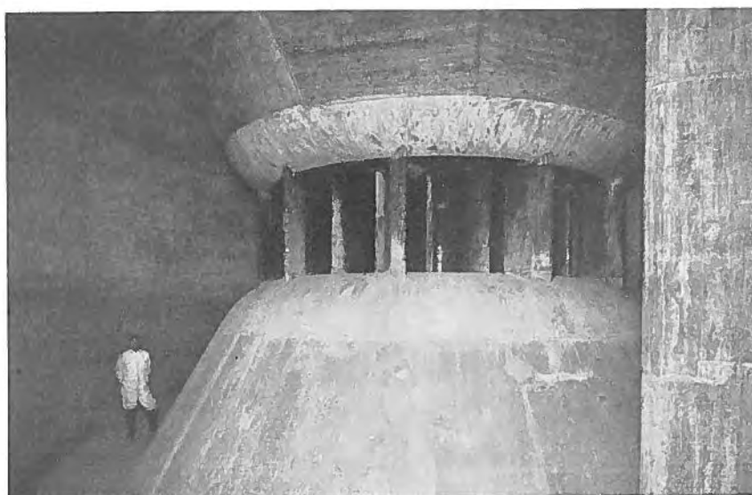
附 圖 カプラン水車コンクリート・ケーシング及ガイドメーン (九州水力三芳發電所)
