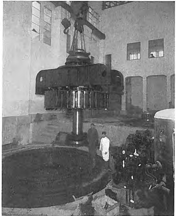
第 3 圖 九州水力 5,000 kVA 發電機 回轉子を上部ブラケット及組立たるまゝの 推力並に上部振止軸受と共に釣上げた所
