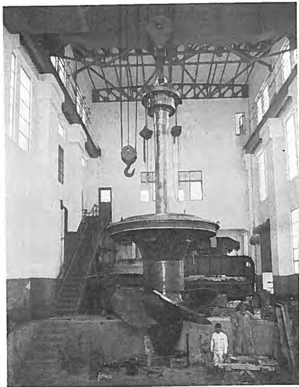
第12圖 九州水力 7,020 H.P. カプラン水車ランナー 発電機室より水車室へ降す處を示す
