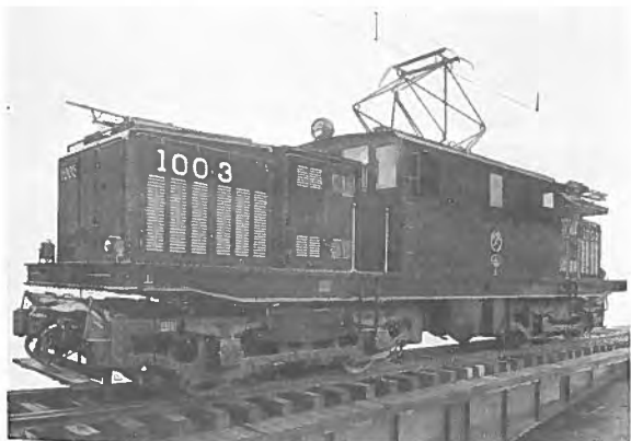
滿洲炭坑向 85 吨電氣機關車
