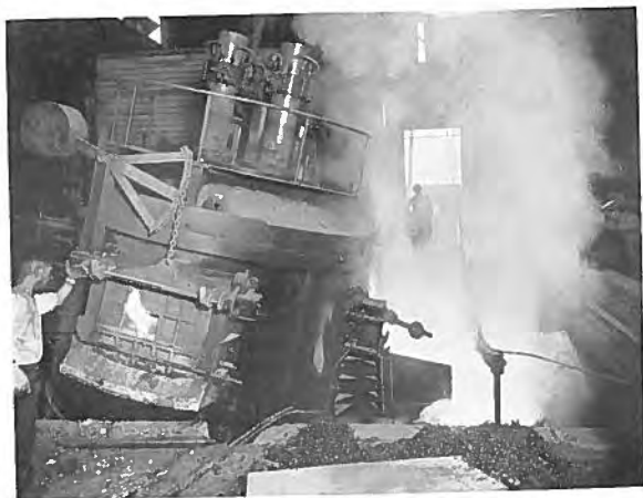
5 廂製鋼用三相エルー式アーク爐
