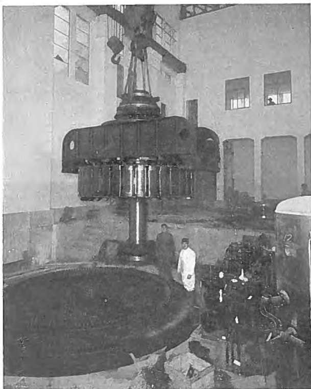
第 2 圖 発電機回転子及び上部ブラケットを示す
