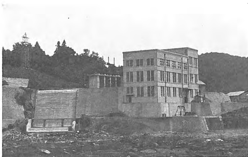
第 1 圖 九州水力電気株式会社三芳発電所全景
