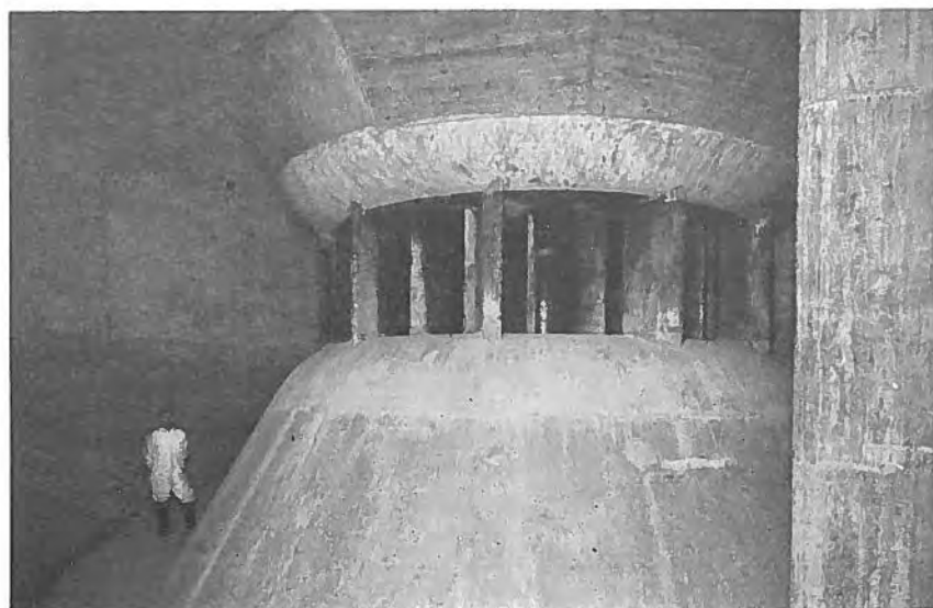
第6圖 水車コンクリート・ケーシング及ガイド・ベーンの一部を示す
