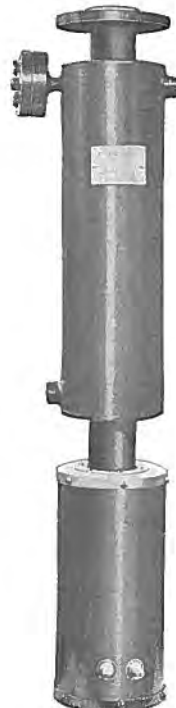
第 2 圖 水銀蒸氣ポンプ
