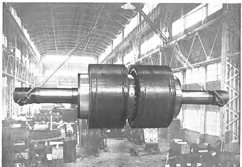
第 3 圖 5000 馬力ミルモートルの二重電機子を示す
