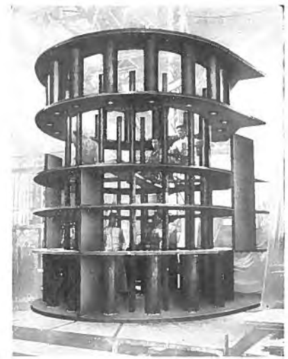
第7圖 銲接中の固定子枠
