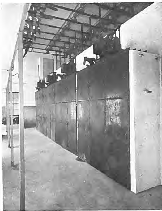
第 2 圖 O-22A 型 屋内用油入遮斷器
