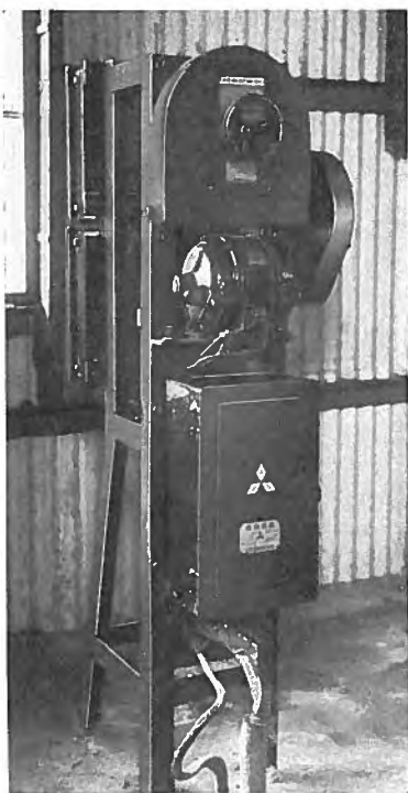
第 24 圖 給炭機用制御装置
