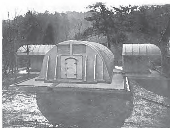
第5圖 日本電力會社神戸變電所納 10,000 kVA 同期調相機
