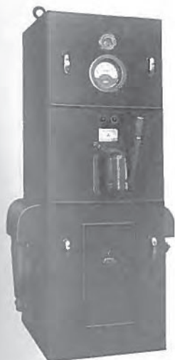
第25圖 キュウビツクル型配電盤
