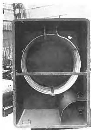
左圖はグラビティー・タンク。本發電機のガイドベアリング並にスラストベアリングはグラビティー給油式であつて、ポンプから汲上げた油を此のタンクに入れ、冷却して各ベアリングに送る。給油容量はポンプの停止から約25分間、3台の發電機に必要な油を保有して居る。
