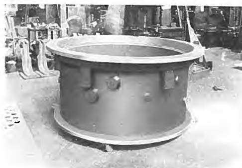
右下圖はスラスト・ベアリング用のボットであつて、此内部にスラスト・ベアリングの主体及冷却管を納め、其内に潤滑油の油層を形成して居る。鑄物であつて此の上部に勵磁機を取付ける。
