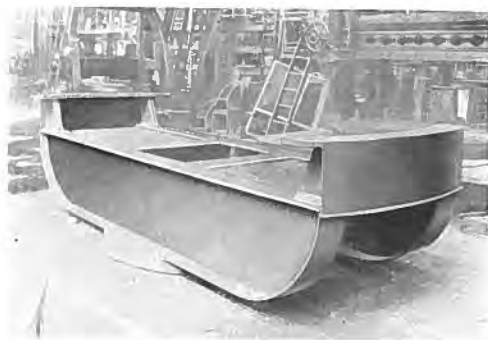
左圖は上部ブラケットであつて、2本のビーム、脚、及通風の格子を示して居る。右圖は上部ブラケットの強度並びにデフレクションの測定を行つて居る所である。
