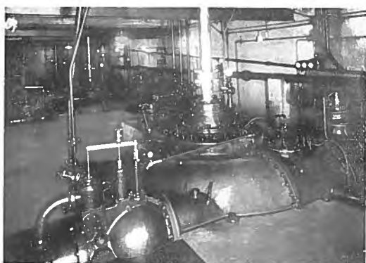
左圖は水車室の全 景であつて、ケー シング、水壓調整 器、バタフライ バルブ等を示して 居る。
