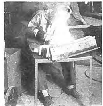
第 2 圖 フレックス・アーク溶接機による溶接作業
