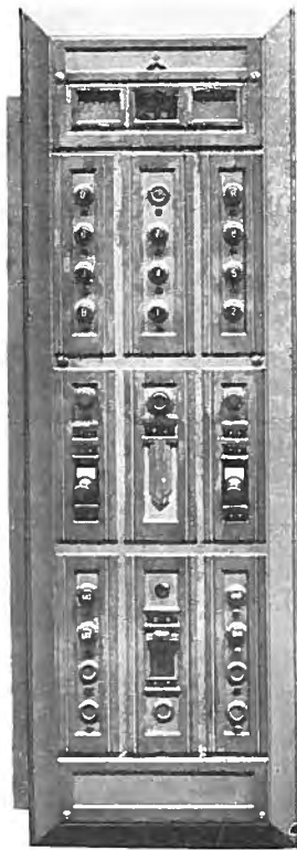
第8圖 エレベーター 押釦制御籠操作盤
