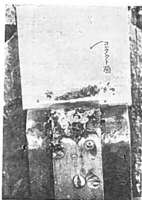
第 13 圖 油入遮断器上部接觸部 デアイオン・グリッド附
