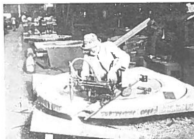
第15圖 自動式瓦斯切斷器による スパイダー鋼材の切斷
