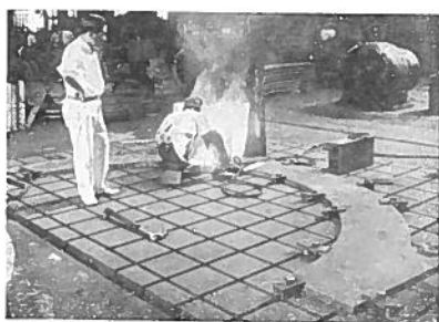
第5圖 固定子フレームの電弧溶接
