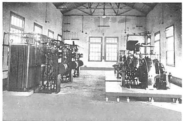
藤の澤變電所内部
