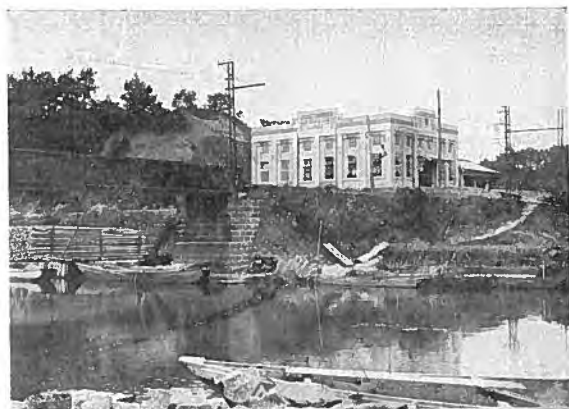
第 1 圖 一畑電鐵布崎變電所
