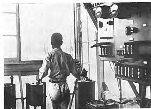
第8図 移動積込機運轉室
