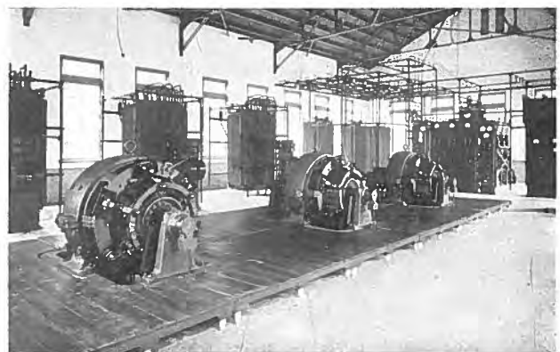
唐櫃變電所内部 500 Kw. 廻轉變流機 3 臺、 525 Kv-a 變壓器 3 臺、440 Kv-a 受電用 變壓器 4 臺配電盤一式を備ふ
