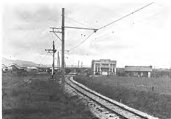
電車線路と架空線 前方建物は猿投變電所
