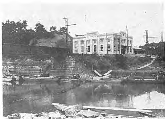
布崎變電所の外景
