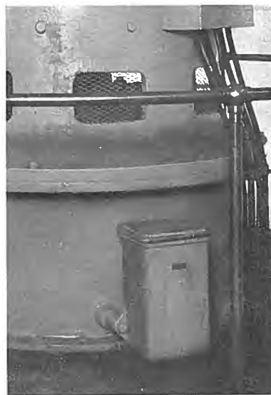
第 12 圖 推壓軸承浮動開閉器 (912q)
