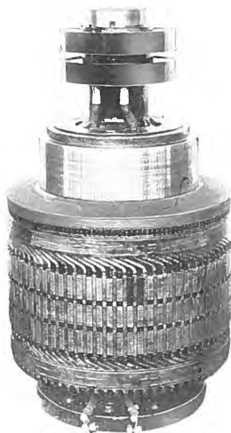
第5圖 勵磁機電氣子
