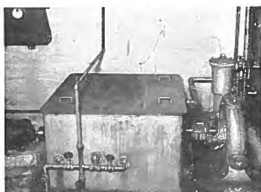
第5圖 軸 承 給 油 装 置
