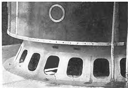
第 1 圖 下方を圓錐狀に開かせてベアリング キャパシチーを大きくしたベース・リング
