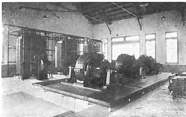
小部變電所の内部 1,000 キロワット廻轉變流機 3 臺、1,065 キロヴォルト・アムペア變壓器 3 臺、配電盤一式を備ふ。
