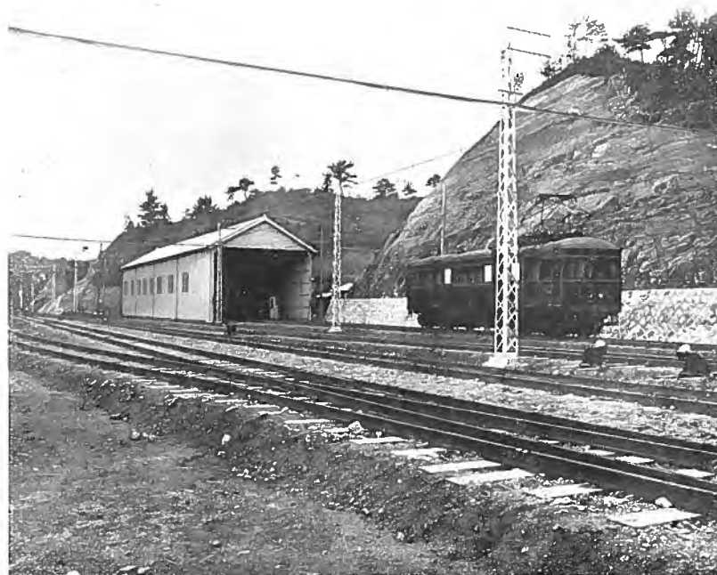
小部驛にある電車車庫、電車6輛を容れ得るもので別に附屬工場があり、旋盤、ボール盤、シーパー、ドリル、グラインダー等を備へ車輛の修理を行ふ様になつて居る
