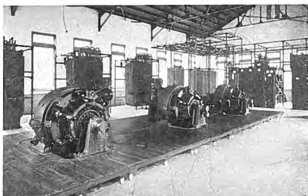
唐櫃變電所内部 500 キロワット廻轉變流機 3 臺、525 キロヴォルト・アムペア變壓器 3 臺、 440 キロヴォルト・アムペア受電用變壓器 4 臺、配電盤一式を備ふ
