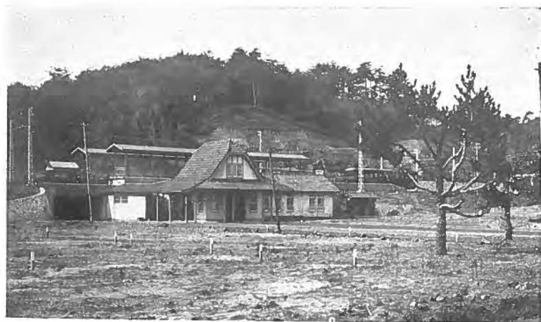
神戸湊川驛から約15分で小部驛に着く。此處から有馬、三田方面へは單線運轉を行つて居る
