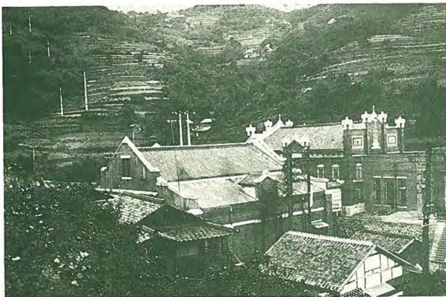
我邦の基督教史上に有名な長崎浦上の天主教會堂近く東邦電力長崎變電所があります。三菱製 5,000 キロ同期進相機が最近据付けられました。
