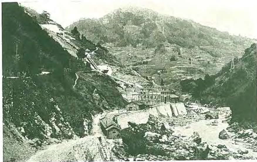
巡禮が御詠歌の聲も悲しく、土佐の國から伊豫の國へさ渉る國ざかひに近く、伊豫鐵道電氣會社の面河發電所が出来上りました。三菱製 4,350 キロ ヴォルト アムペア型水車發電機二臺が運轉されて居ります。
