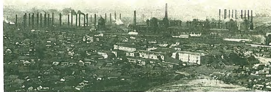
北九州の天を覆ふ製鐵所の黒煙も 25,000 キロ三菱ターボ 發電機の据付けと共に一掃せられることになる
