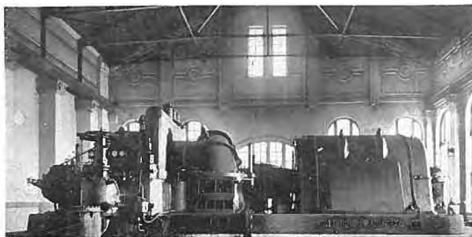
舊大阪電燈會社納（現大同電力春日出第二發電所） 12,500 キロヴォルト アムペア 力率 80 パーセント 11,000 ヴォルト 1,800 廻轉（毎分）60 サイクル 三 相 閉 鎖 通 風 型 交 流 發 電 機
