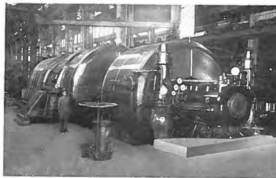
發電機：—25,000 キロヴォルト アムペア 3,500 ヴォルト 力率 80 パーセント 三相 25 サイクル 1,500 廻轉(毎分)閉鎖通風型交流發電機 タービン：—20,000 キロワット 1,500 廻轉(毎分) 二汽笛三菱ツェリー タービン
