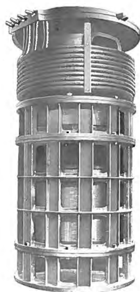
第五圖 RW 三相誘導電壓調整器固定子
