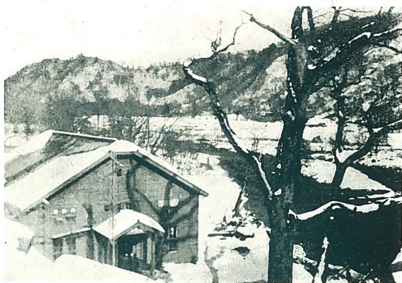
雪にうづもれて春を待つ 鳥海電力會社袖川發電所
