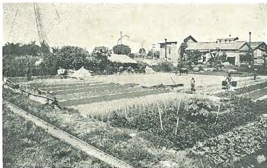
バナ、の香満てる臺灣の南、嘉義の町に氣もちのいゝ音を立てゝ 三菱ユングストローム ターボ発電機が運轉を始めました
