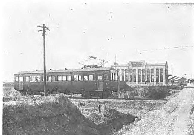
第 一 圖 刈 谷 變 電 所 と 電 車
