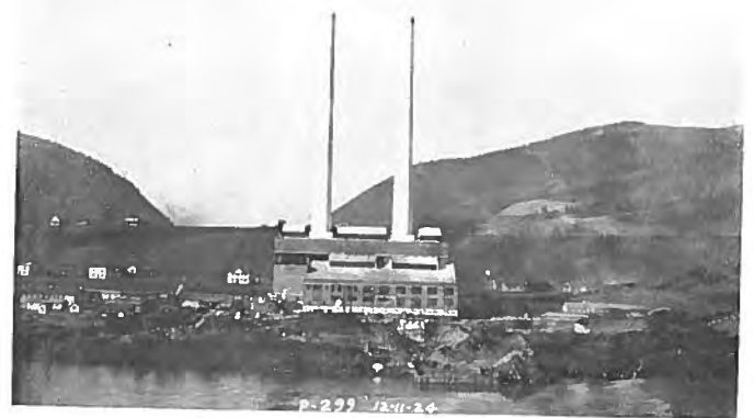
第 五 圖 完成に近づきつゝある Narrow 新發電所
